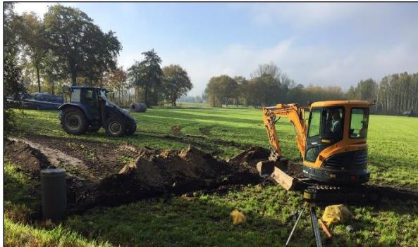
Figuur 7. Omvormingswerken van klassieke naar peilgestuurde drainage te Bocholt.
